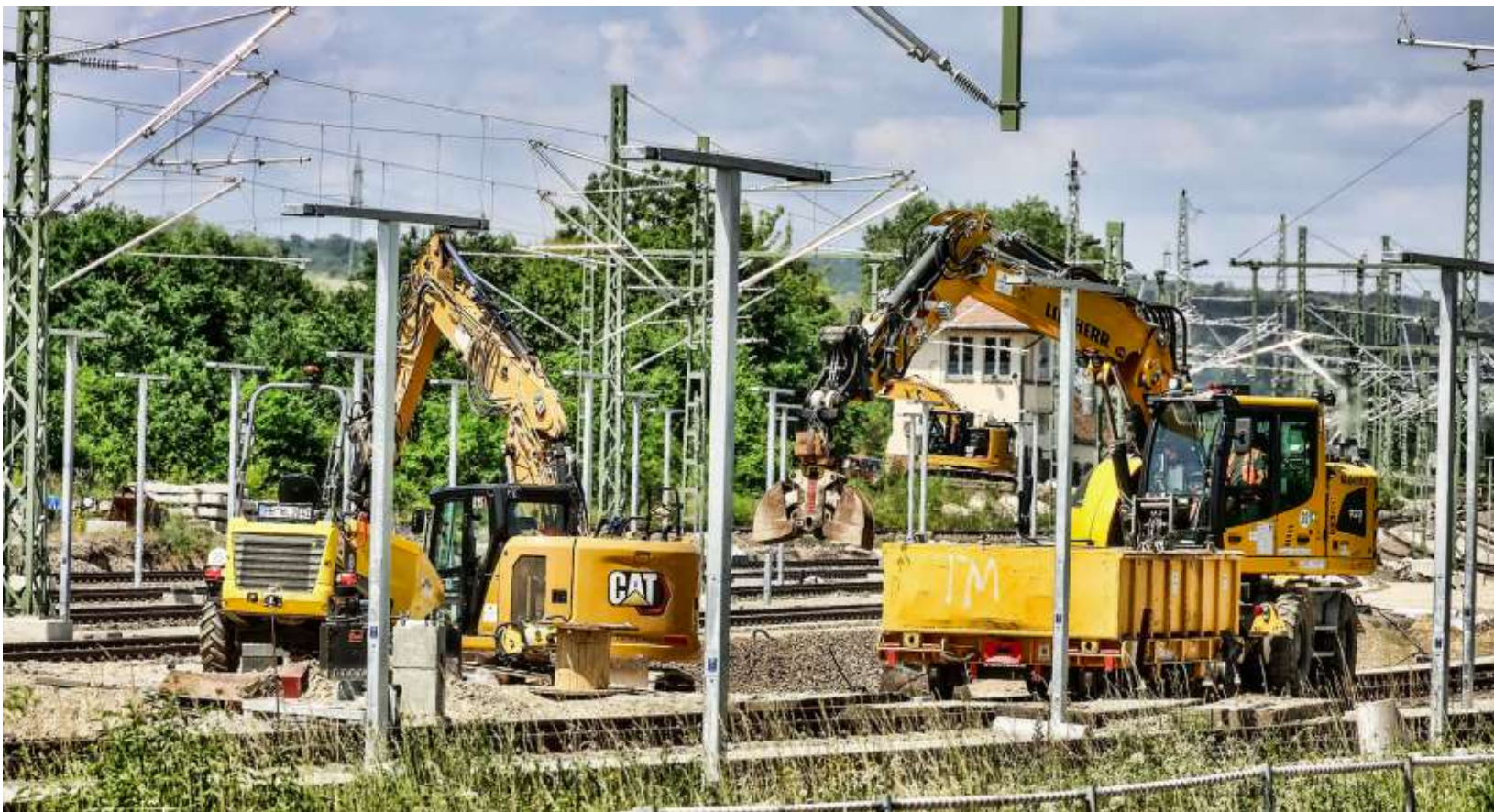
Im Zusammenhang mit der Komplettsanierung zwischen Halle und Kassel baut die Bahn in Röblingen am See Überholgleise für Güterzüge.
